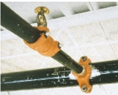
El sistema FIT proporciona una alternativa de extremo liso para sistemas de rociadores de derivaciones, rejilla o adaptados, con rosca y acoplados.
