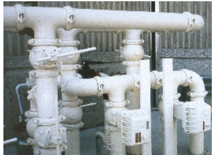
Las válvulas Vic-Plug™ proporcionan un montaje de extremo ranurado fácil con control manual o automático, según sea necesario.
