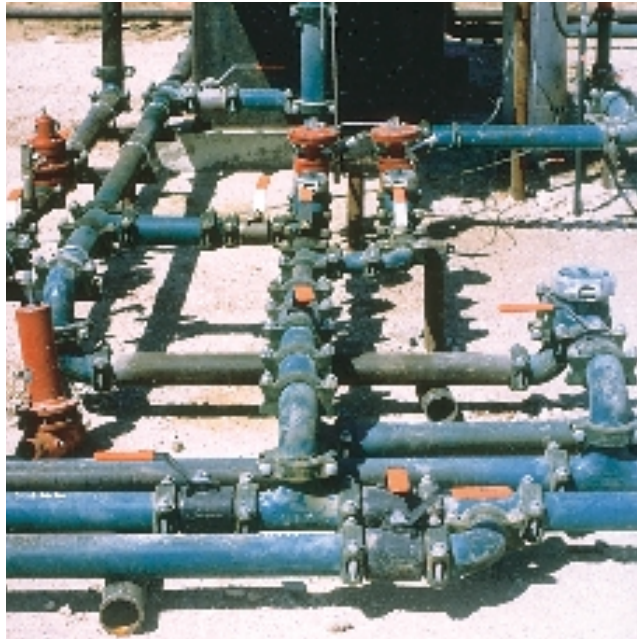
Tubería completa del grupo o batería de estanques desde la boca del pozo hasta el oleoducto - acoplamientos, conectores, válvulas
