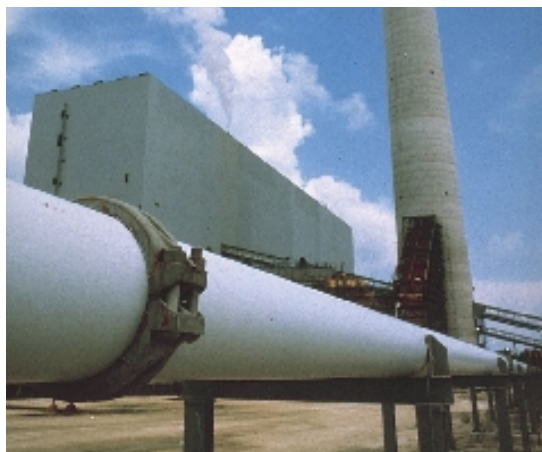
Los acoplamientos de extremo liso proporcionan una unión de pared de grosor completo para sistemas abrasivos
