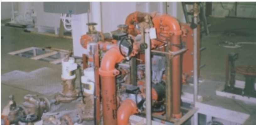
Tubería a bordo de embarcaciones marítimas utiliza acoplamientos rígidos y flexibles para necesidades especiales.
