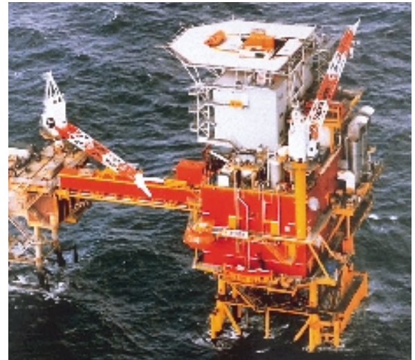
Líneas completas de retorno de lodo, desagüe, agua costafuera y otras líneas de producción.
