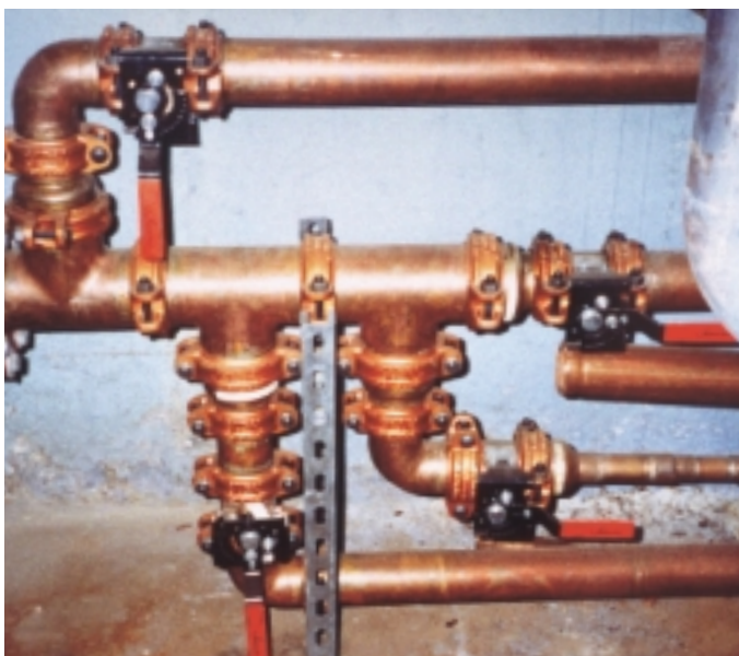
Un paquete completo de acoplamientos, conectores, adaptadores de brida y válvulas de mariposa de cobre (CTS).
