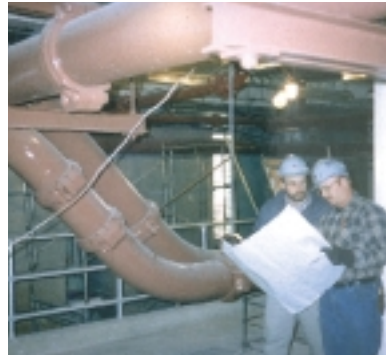
Acoplamientos Duo-Lock™ de doble ranura proporcionan compatibilidad de alta presión para sistemas de tuberías de torta de cieno.
