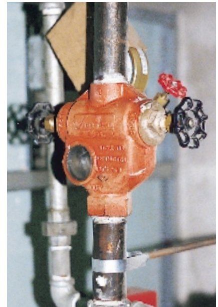
El módulo para probar alarmas TestMaster™, las válvulas FireBall más las válvulas de retención FireLock y otras proporcionan control de flujo de sistemas.
