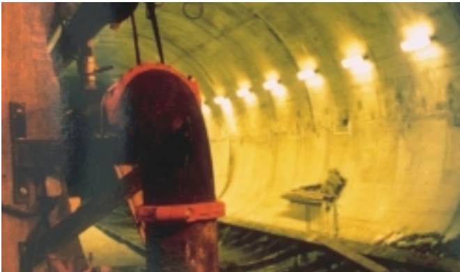
El sistema ranurado facilita la tubería de túneles, amortigua la vibración y acepta el movimiento térmico.
