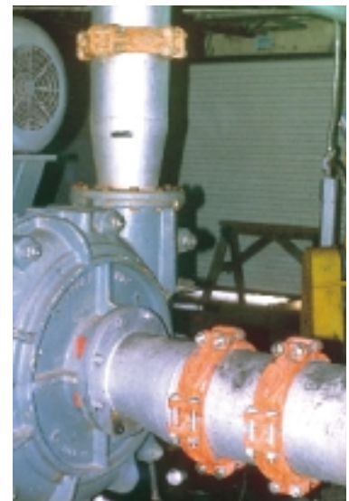
Los sistemas lisos dejan todo el espesor de la pared para servicios abrasivos.
