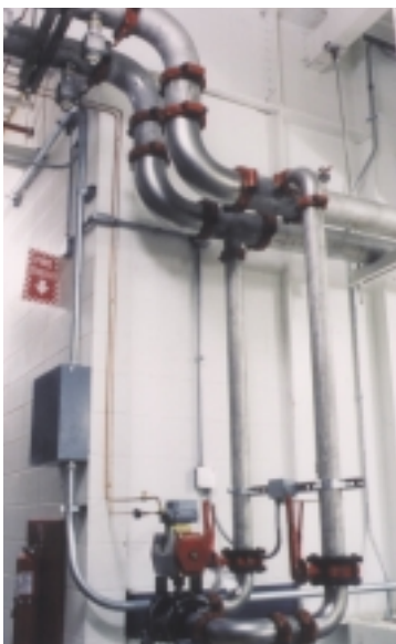
Acero inoxidable, ambos 316 y 304, pueden conectarse con acoplamientos estándar o de acero inoxidable.
